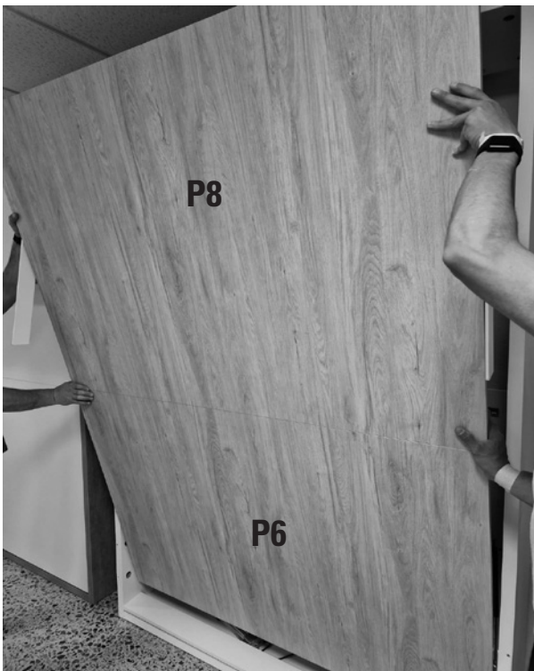
14 PLACER LA FAÇADE SUPÉRIEURE (P8) AU DESSUS DE LA FAÇADE INFÉRIEURE (P6)
