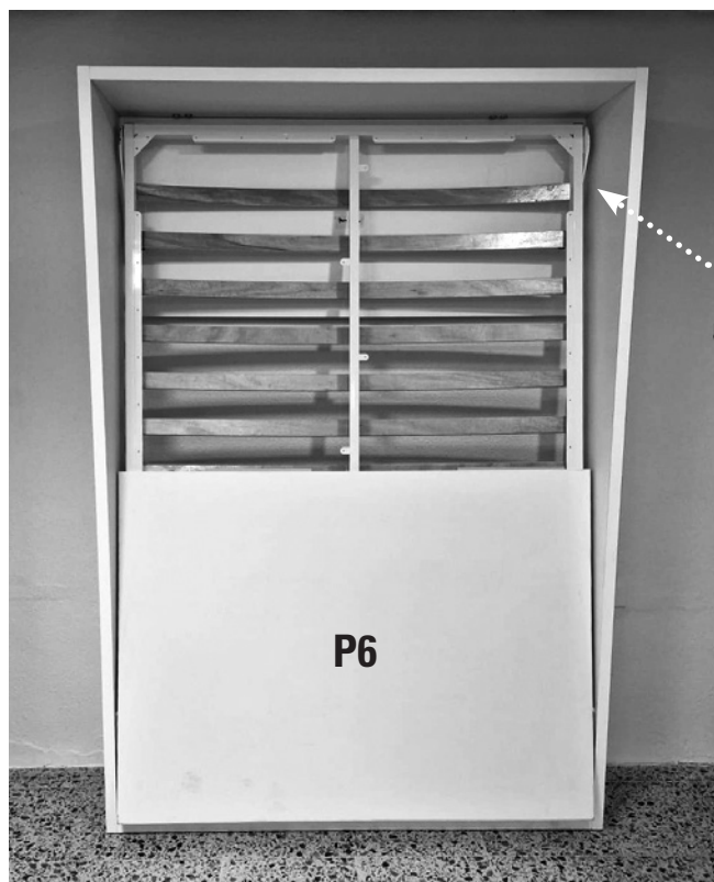
9 POSITIONNER LE CADRE DE L'ARMOIRE-LIT COMME SU L'IMAGE VERS L'INTÉRIEUR DE LA STRUCTURE
